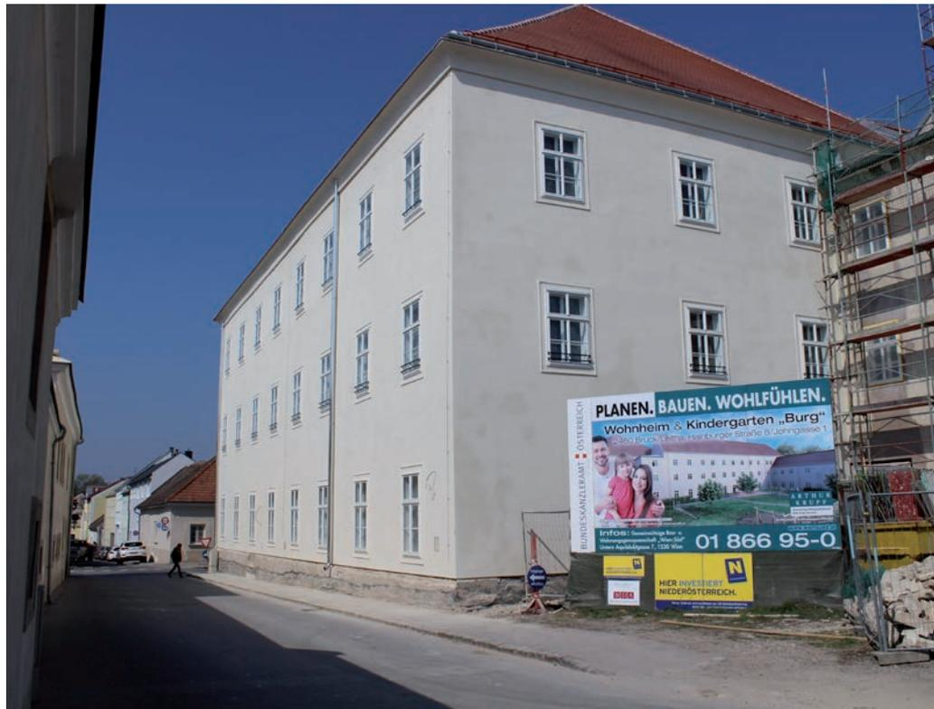
und der Mauerwerksaustausch im Westtrakt, die Fassadensanieerung in der Hainburger Straße, die Dachsanieerung im Nordtrakt, der Fenstertausch in Abstimmung mit dem Bundesdenkmalamt, die Trockenbauarbeiten im
